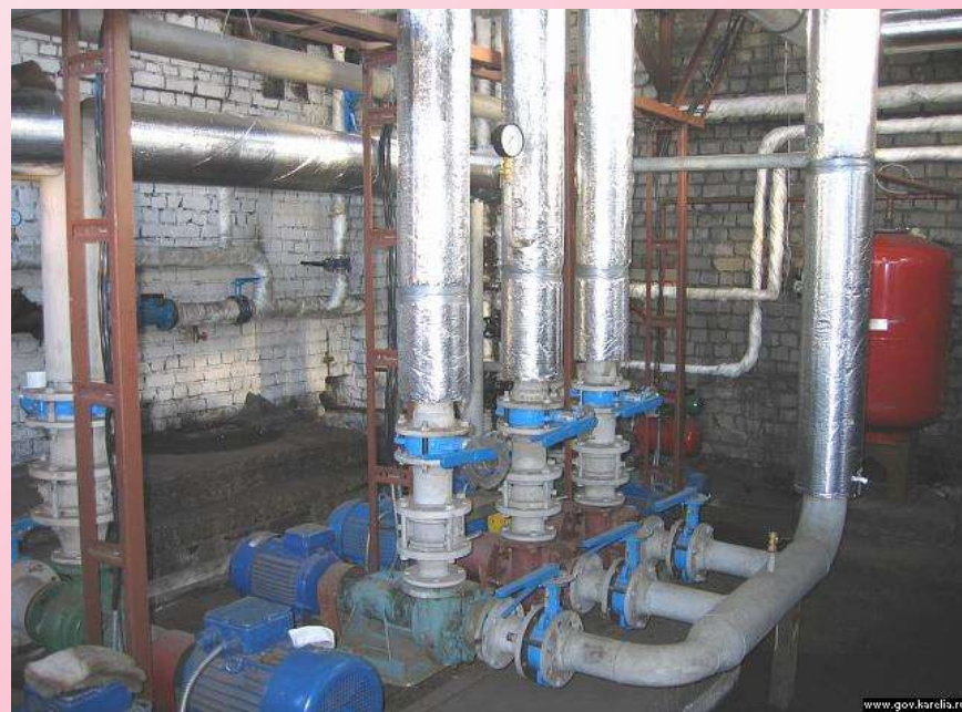
Котельная № 15 г. Беломорска после проведения капитального ремонта
